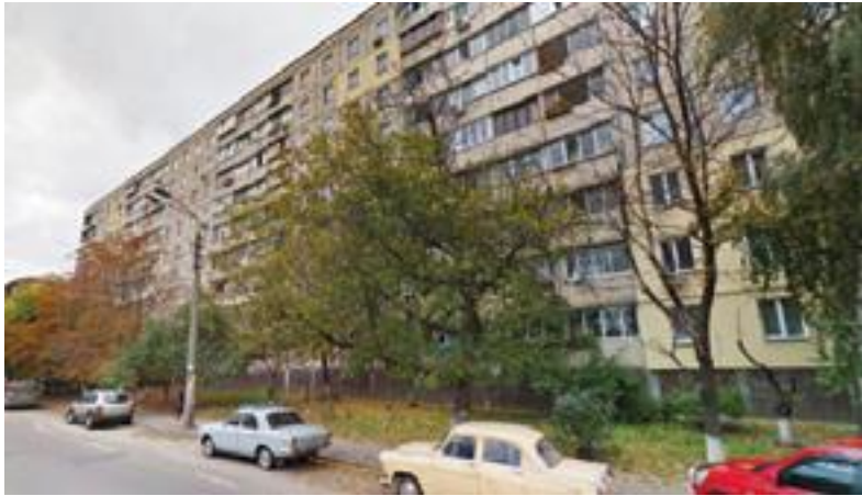
м. Київ, вул. Голосіївська, 16. Побудована у 1979 р.
