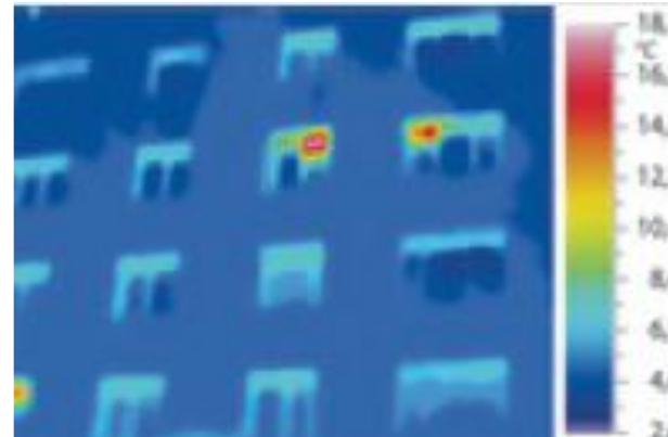
Теплограма після модернізації (тепло йде тільки через відкриті квартирки)
